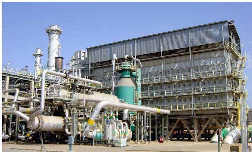
Fig. 1. The steam-reforming unit.
